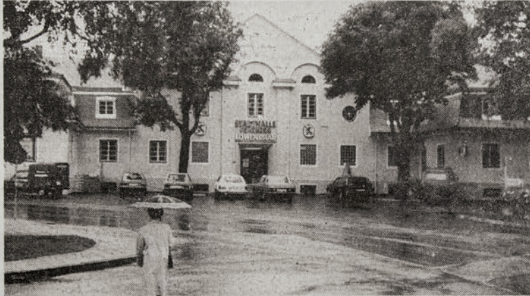
Jetzt kann sie sich wieder sehen lassen, sowohl innen wie außen! Mit drei großen Feiern wird ab heute die Stadthalle nach der Renovierung wieder eröffnet. Foto: zek.
