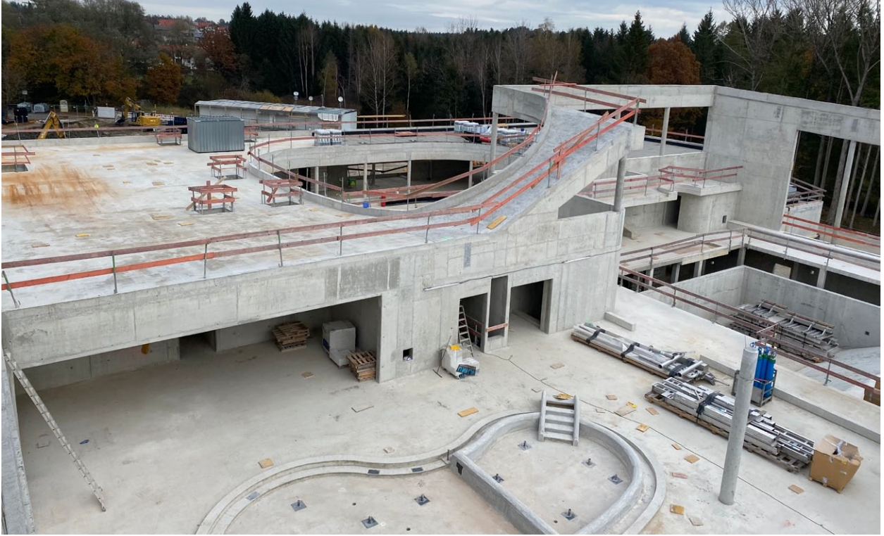
Abnahme Rohbau am 27.10.2021 – Kinderbecken mit Gastronomie, Stahlbetondecke über Saunabereich, Schwimmerbecken und Galerie © Stadtwerke Penzberg
