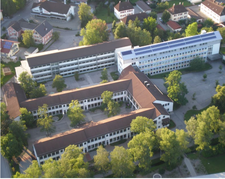
Schulgebäude Südstraße © Hans Mummert
