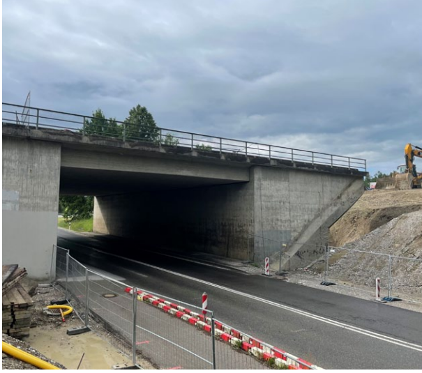
Arbeiten an der Autobahnbrücke - Anschlussstelle Penzberg/Iffeldorf, © Stadt Penzberg
