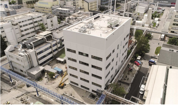
Neubau Diagnostik Produktion © Roche
