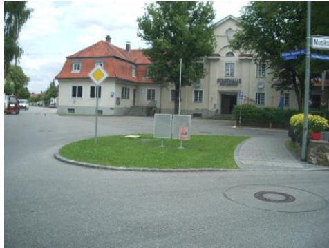
Vorplatz vor Stadthalle auf Grünfläche bei Brücke
