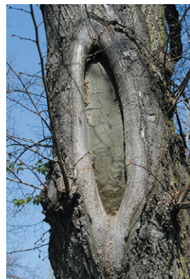
Links: Starkastschnitte führen langfristig zu Fäule. Diese Schnittführung entspricht nicht mehr dem aktuellen Stand der Technik
