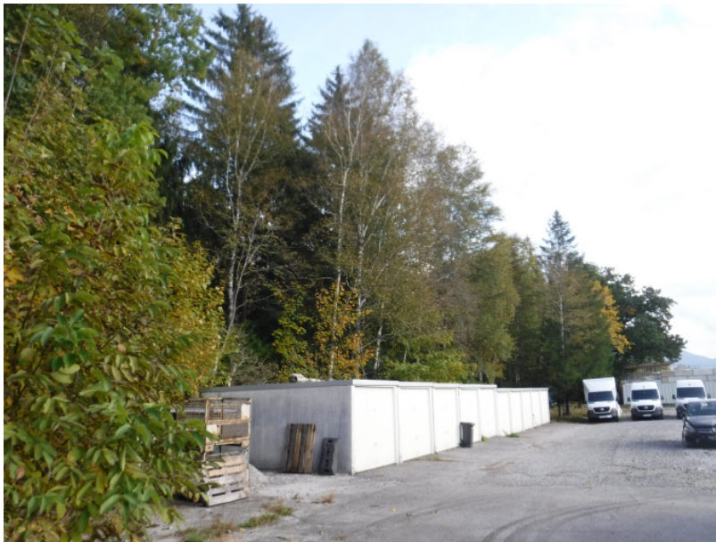
Abb.1: Fertiggaragen Fl.-Nr. 1143/49, Blick nach Osten
