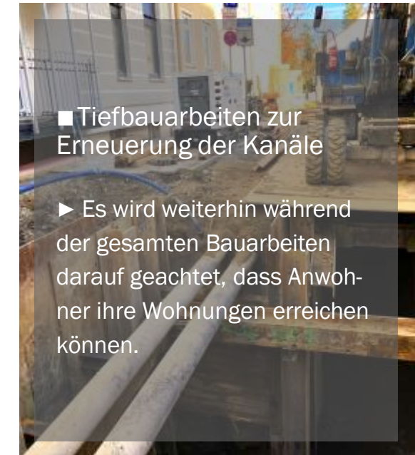
Philippsstraße: Bohrung für den Baugrubenverbau des Mischwasserkanals
